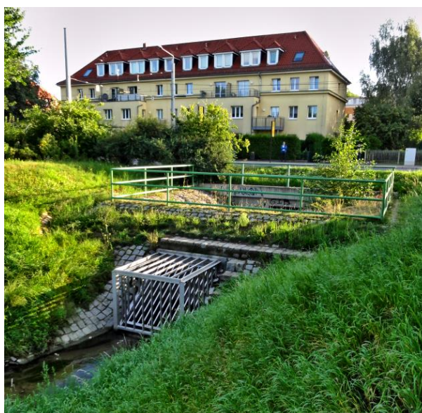
Bild 3.1 Systemskizze (links) und Foto des vorhandenen Drosselbauwerks am HWRB Kaitzbach 1 (Hugo-Bürkner-Park)
